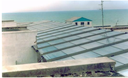
Рисунок 3 – Одноконтурна сонячна система у теплоенергетичній установці
